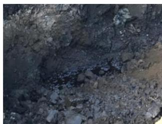
オイルスポンジゴールド+を散布し良くかき混ぜ、土を水に入れて油膜がでなければ作業完了
