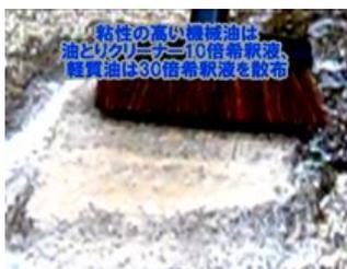
油とりクリーナーの希釈液で隙間に入った油を剥離
